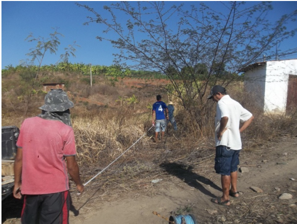
Während der Bodenanalyse für die Tiefbrunnenbohrung
